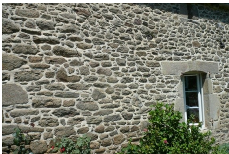
Exemple de joints extérieurs chaux/sable
