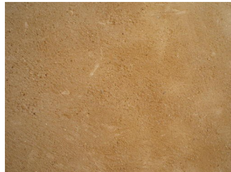
Exemple d'enduit de finition à la chaux
