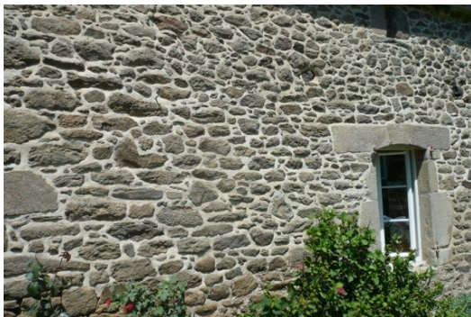
Exemple de joints extérieurs chaux/sable
