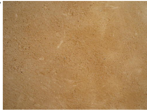
Exemple d'enduit de finition à la chaux
