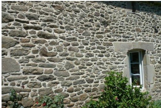
Exemple de joints extérieurs chaux/sable
