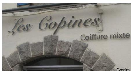
Exemple d'une ouverture cintrée et formée de pierres apparentes
