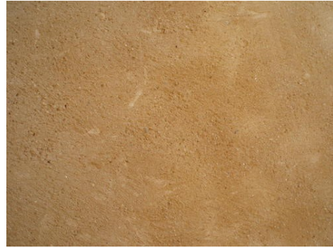
Exemple d'enduit de finition à la chaux
