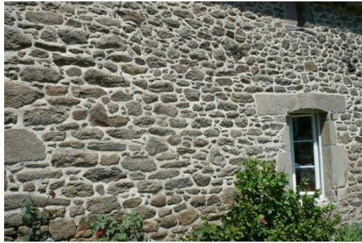
Exemple de joints extérieurs chaux/sable
