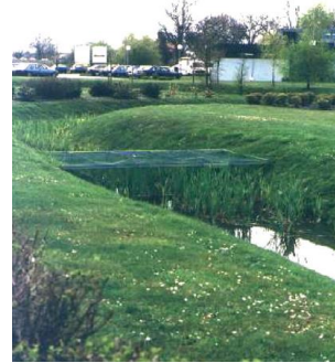
Bassin de rétention
