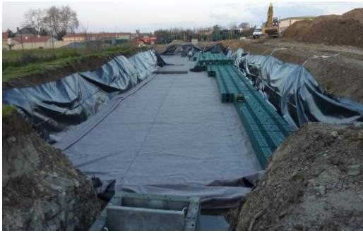
Bassin de rétention
