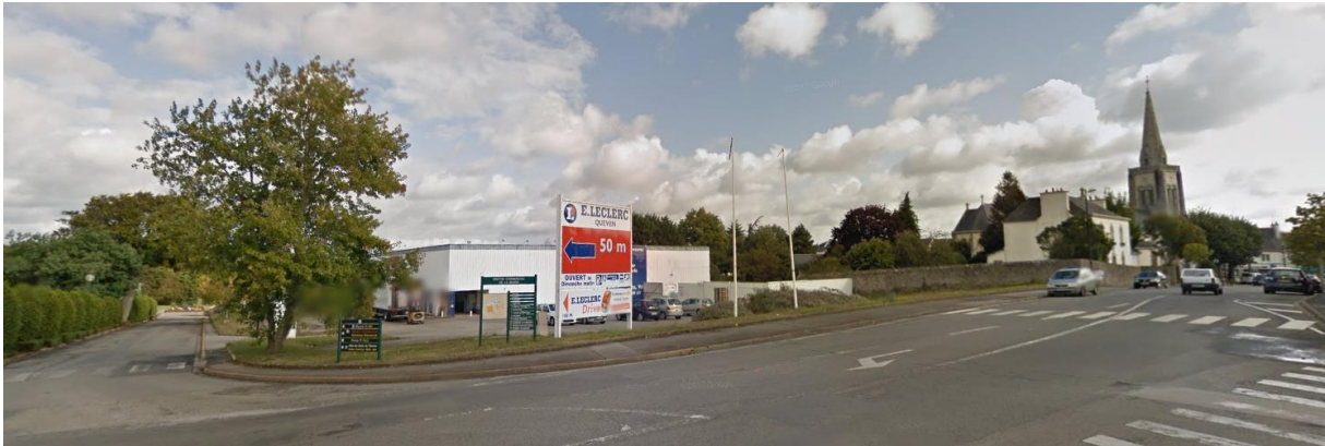
Aperçu du site avant déconstruction de l'ancienne surface commerciale depuis la rue Diény au Sud
