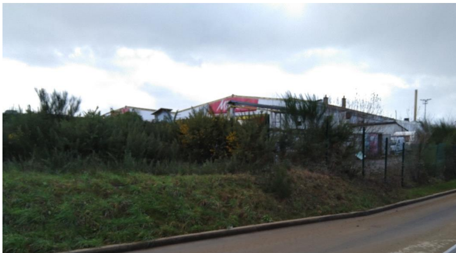
Aperçu du site depuis la rue Lejeune au Nord
