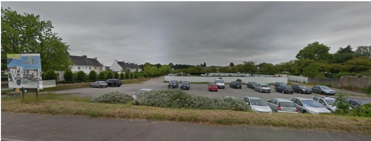
Aperçu de la friche après déconstruction depuis la rue Diény au Sud
