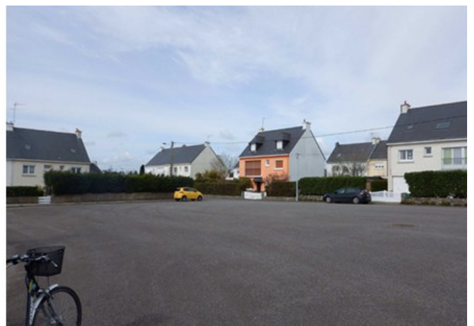
Des espaces en enrobés surdimensionnés
