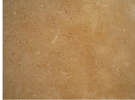
Exemple d'enduit de finition à la chaux
