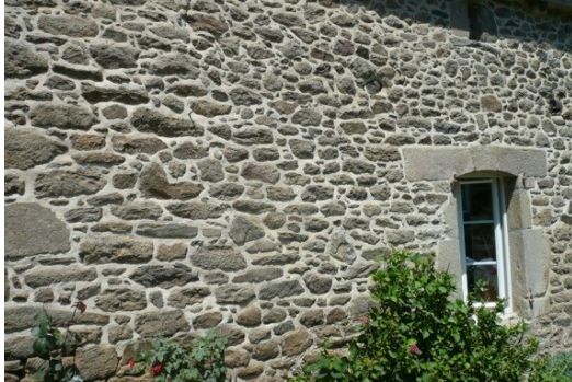
Exemple de joints extérieurs chaux/sable
