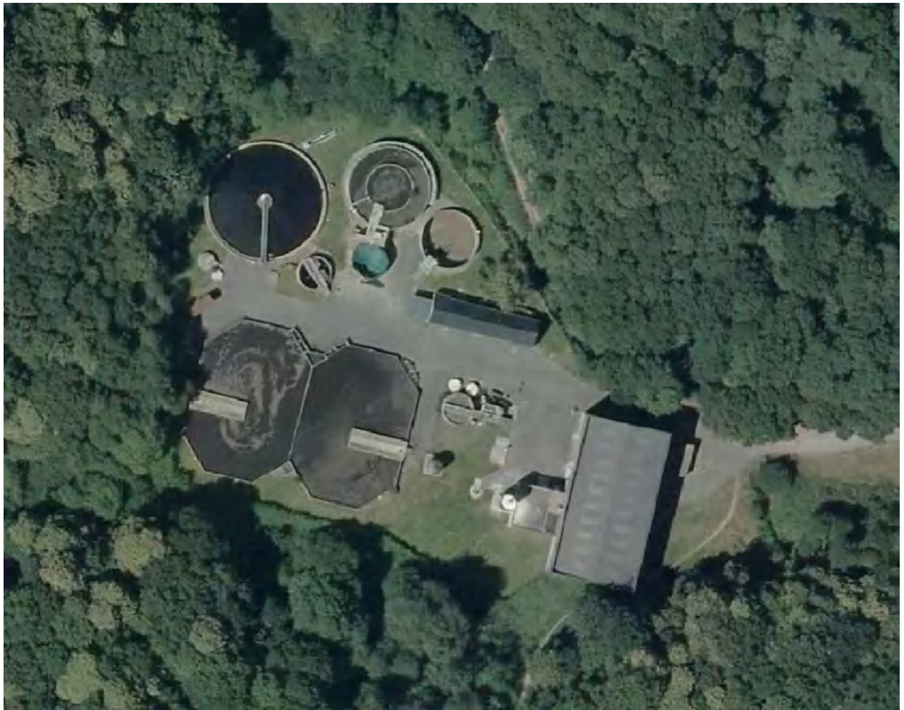
Figure 23 : station d'épuration de Quéven - Source : Orthophoto - 2016
