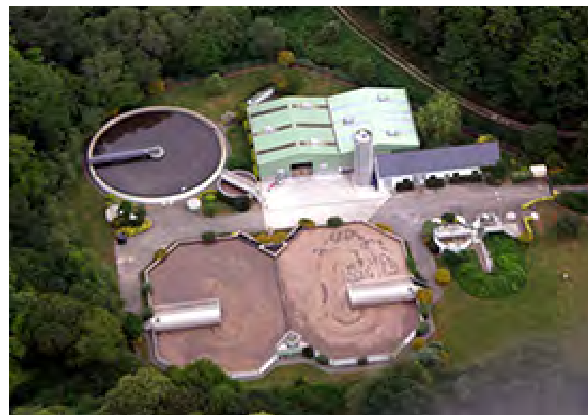
station d'épuration existante
