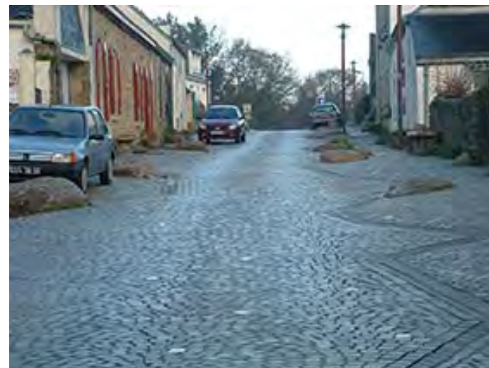
la rue de la Promenade après son réaménagement
