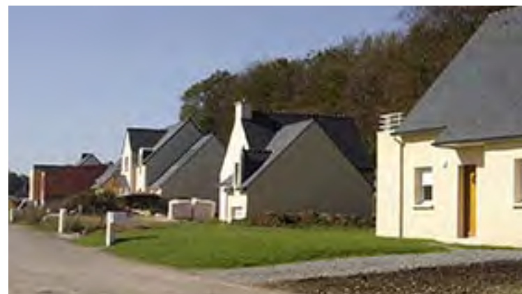
lotissement en construction
