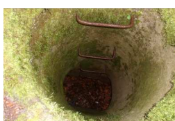
Regard et canalisation de l'ancien réseau d'eau de la ville de Lorient
