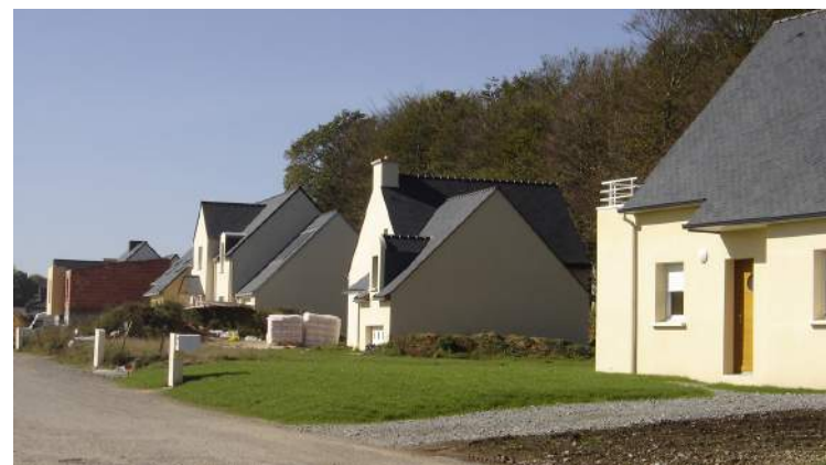
lotissement en construction
