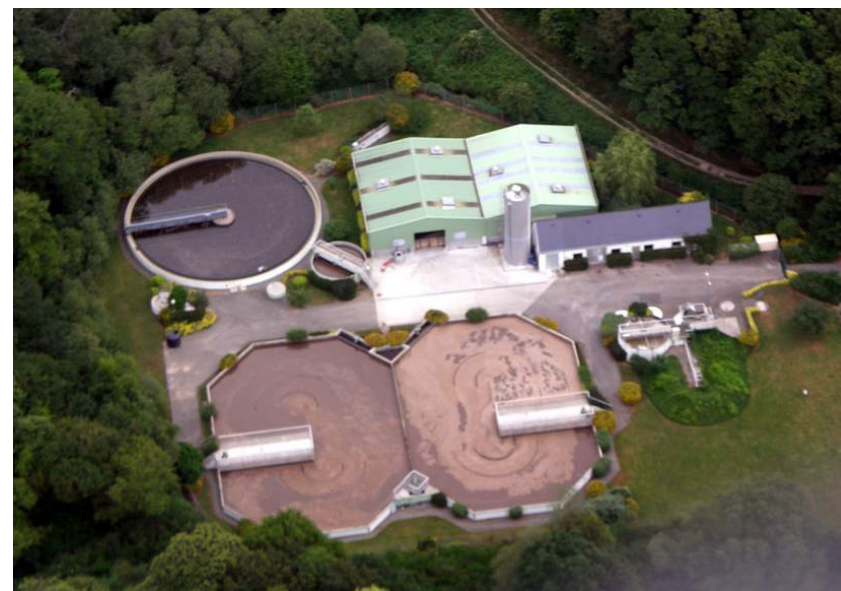
station d'épuration existante
